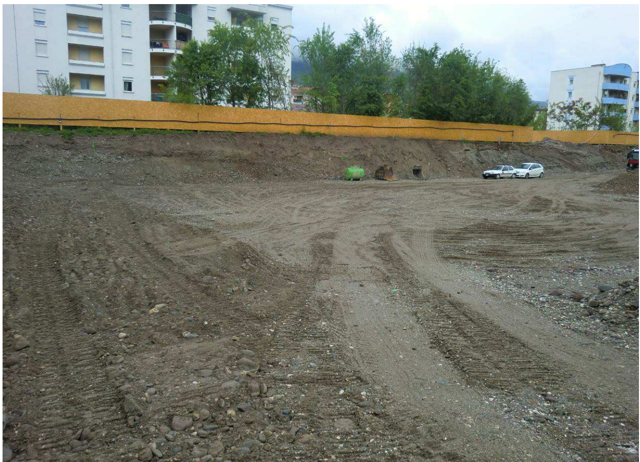
Foto 4: Aushubsole der Bodensanierung in kiesig-sandigen Böden, Blick Richtung N
