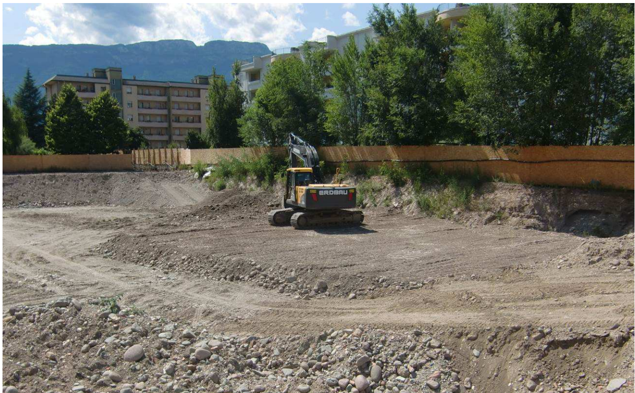
Foto 6: Wiederverfüllung mit kiesig-sandigem Material im Rahmen der Bodensanierung im Projektgebiet im Juni 2012, Blick Richtung W
