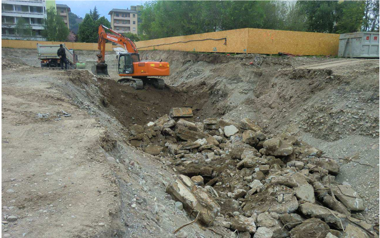
Foto 3: Aushub im Rahmen der Bodensanierung im Projektgebiet im April 2012, Blick Richtung W, im Vordergrund erkennt man die extrahierten Baurestmassen, rechts davon den natürlichen Kiesuntergrund
