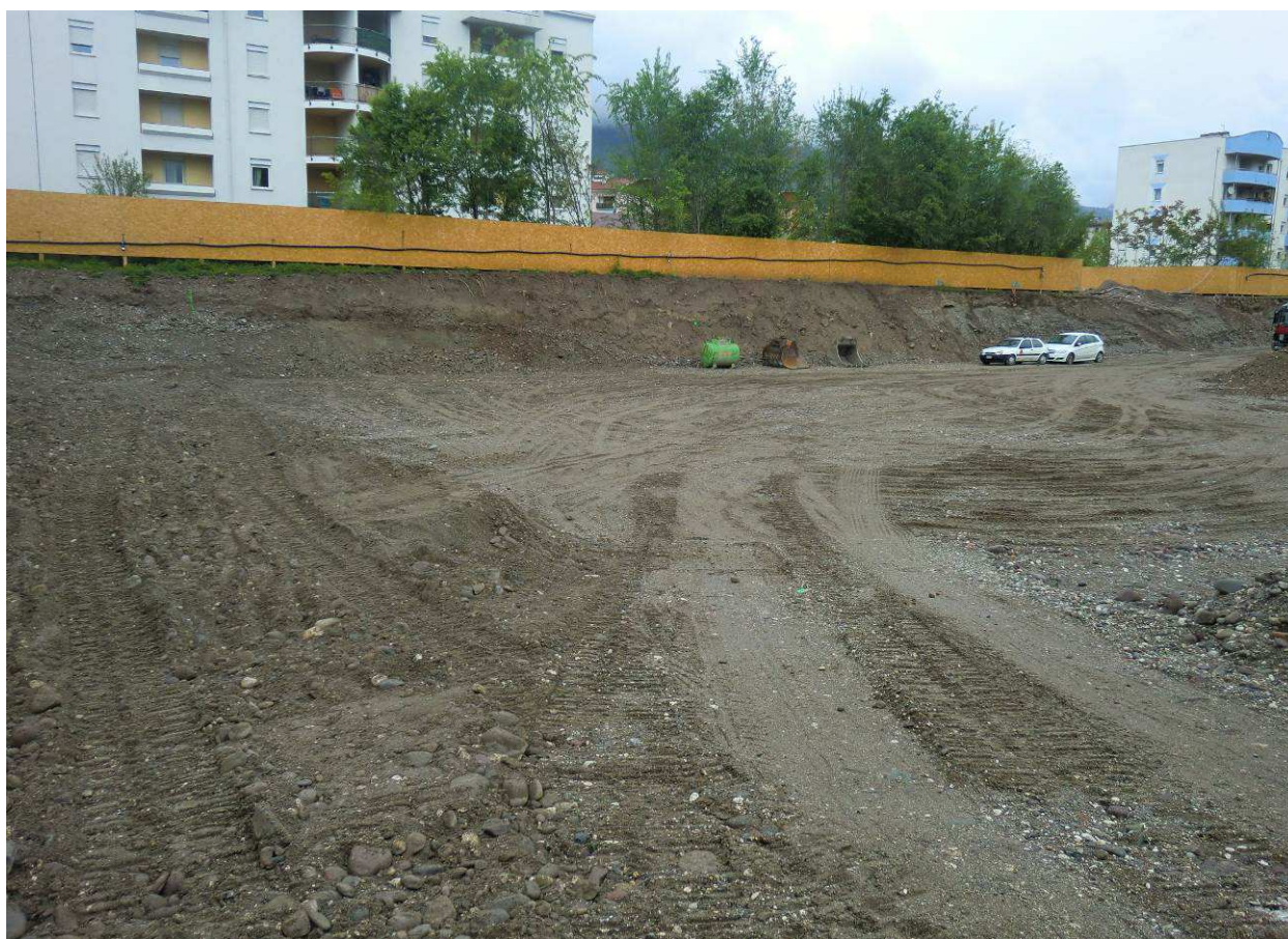
Foto 4: Fondo scavo della bonifica ambientale in terreni naturali ghiaio-sabbiosi, vista verso N
