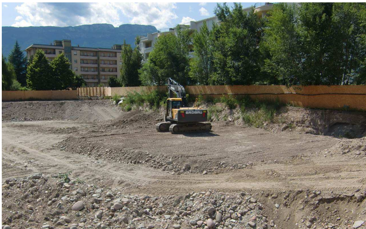
Foto 6: Fase di rinterro con materiale ghiaio-sabbioso nell'ambito della bonifica ambientale nell'area di progetto in giugno 2012, vista verso W
