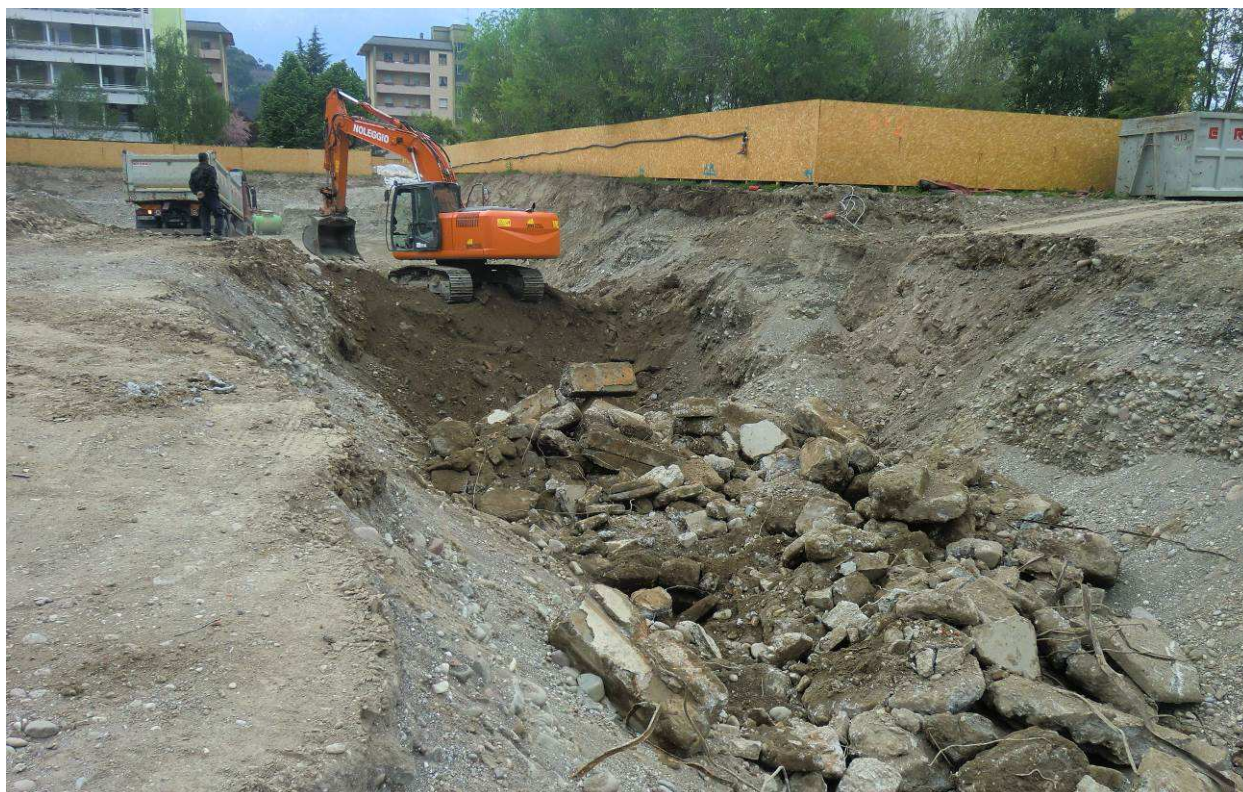
Foto 3: Fase di scavo per la bonifica ambientale nell'area di progetto in aprile 2012, vista verso W, in primo piano si notano i materiali di demolizione estratti, più a destra il sottofondo naturale ghiaioso
