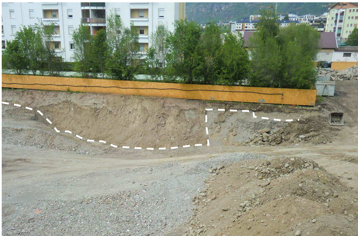
Foto 5: Fase di scavo per la bonifica ambientale nell'area di progetto in aprile 2012, vista verso NW, con un dettaglio sulla scarpata sul lato settentrionale, dove si nota bene l'estensione dei riporti non bonificati che poggiano sopra il sottosuolo naturale (limite = linea bianca tratteggiata)
