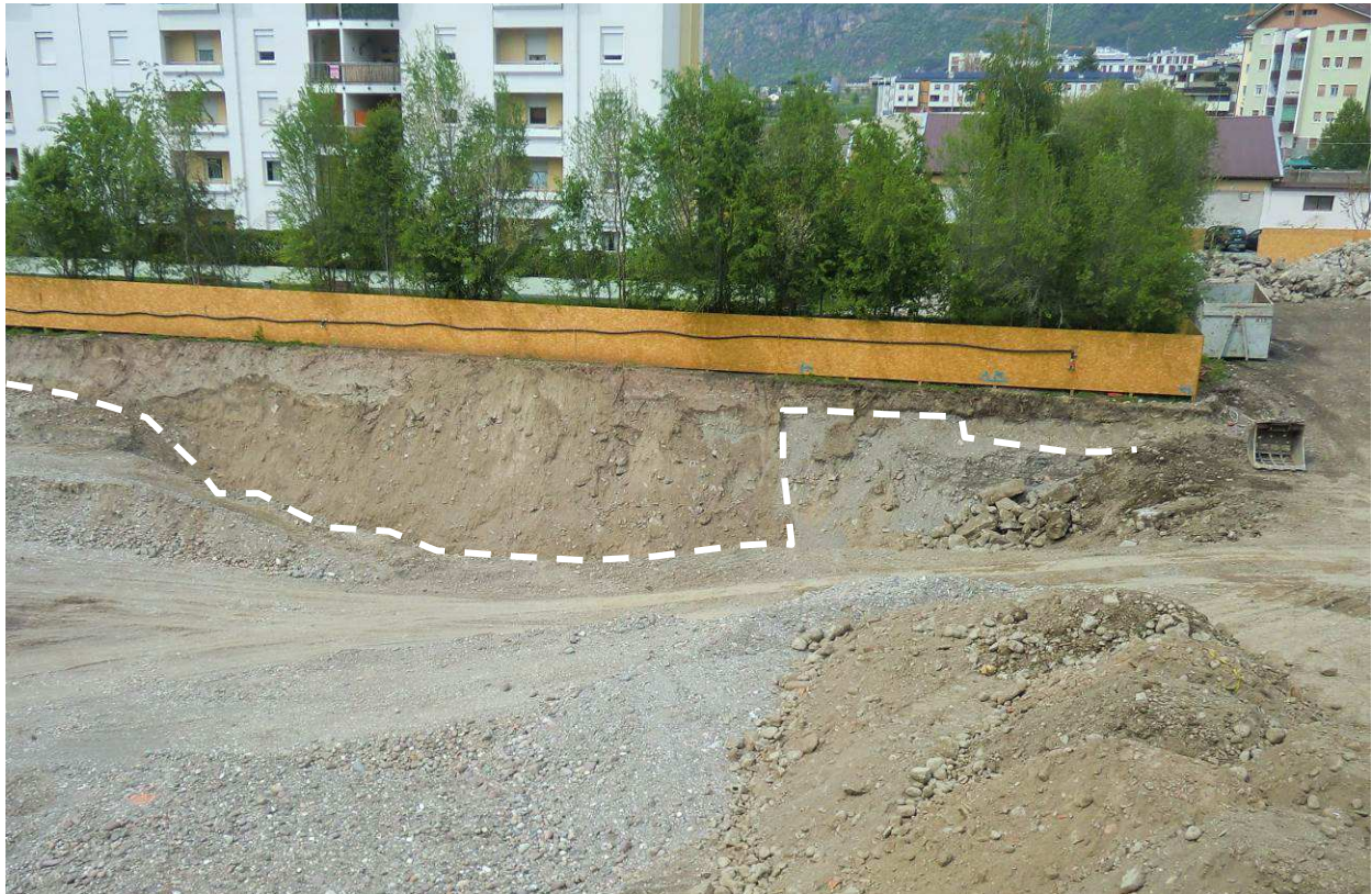
Foto 5: Aushub im Rahmen der Bodensanierung im Projektgebiet im April 2012, Blick Richtung NW, mit einem Detail der Aushubböschung auf der Nordseite, wo man deutlich die Erstreckung der nicht sanierten Aufschüttungen über dem natürlichen Untergrund erkennt (Grenze= weiße strichlierte Linie)
